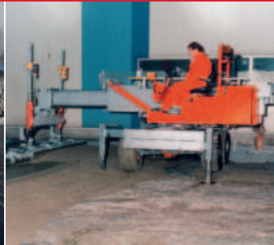
Einbau mit Flächenfertiger (Laserscreed). Poured using a concrete finisher (Laser Screed).
